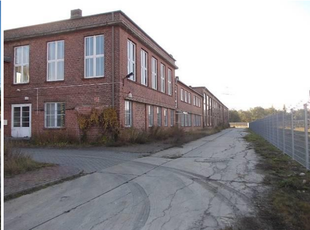
Abbildung 8: Südliche Zufahrt mit Gebäudebestand
