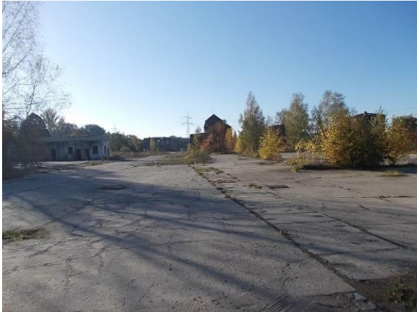
Abbildung 7: zentrale Zuwegung mit angrenzenden Betonflächen
